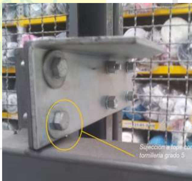
Imagen 14. Tornillería en los anclajes
